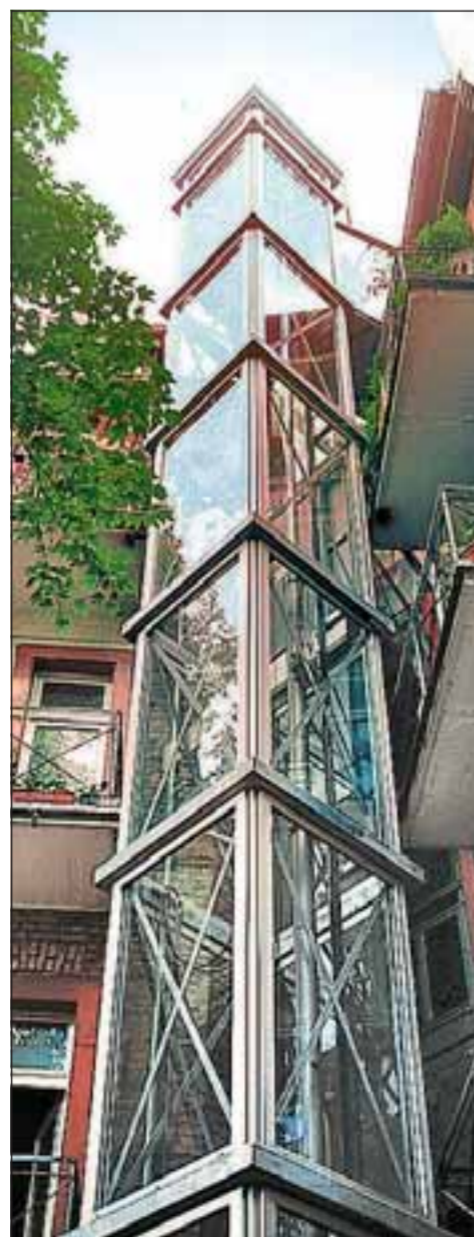
Verbindet Alt und Neu: Aufzug an der Außenwand. Foto: Sturm
