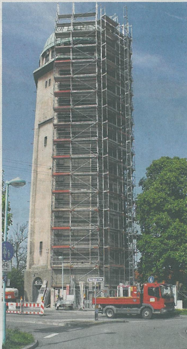
Bis auf 35 Meter Höhe läuft das Bagerüst. Der Seckenheimer Wasserturm wird derzeit innen wie außen saniert und das Aufzugsmuseum erweitert. Bild: Warlich
