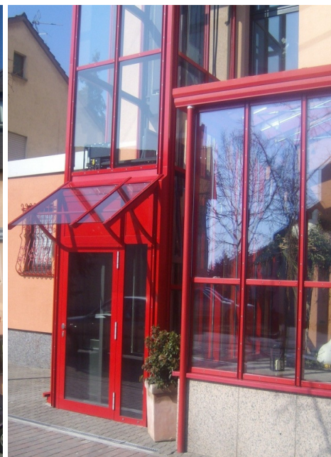
optische Anpassung des Gerüstes an den vorhandenen Wintergarten
