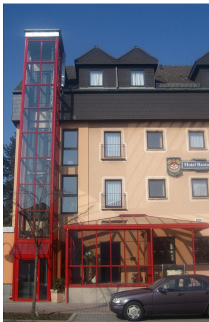
Hotel mit Aufzug im glasverkleideten Stahlschachtgerüst
