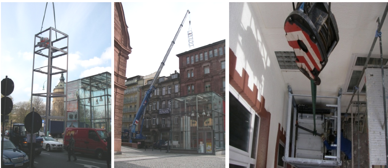
Fotos: Das 18 m hohe Schachtgerüst wird über die Häuserfront zur Montage in den Hinterhof gehoben.
