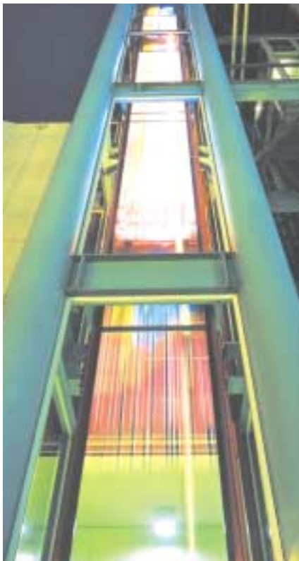
Personenaufzug Stadthaus Mannheim
