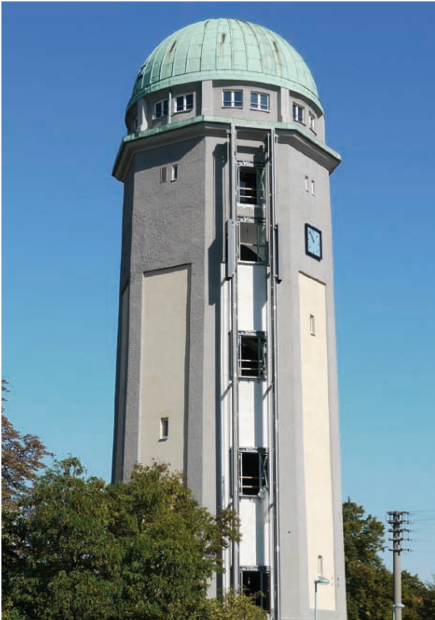
Alle Betonflächen und Pfeiler wurden abgestrahlt und komplett saniert.
