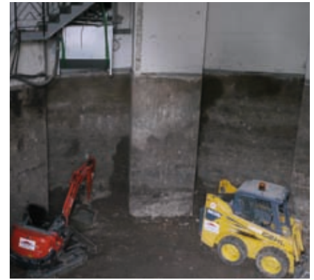
Alle Betonflächen und Pfeiler wurden abgestrahlt und komplett saniert.
