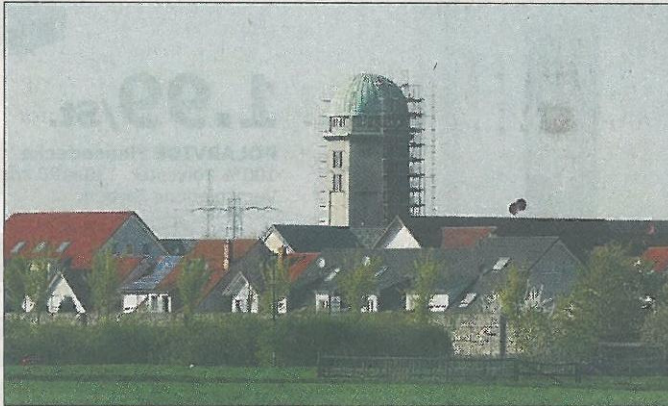
Der historische Wasserturm wird derzeit saniert.
