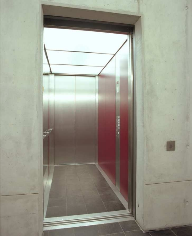
Wände Resopal, Glaslichtdecke, Steinbodenbelag (7290)
