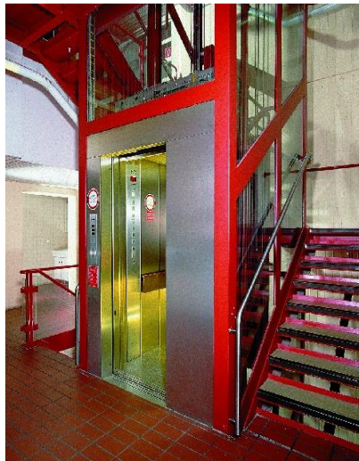
Stahlgerüste mit Glas im Treppenauge
